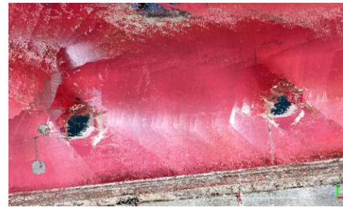
図 4: 床材の SfM 解析結果 (エントランス 2 階)
