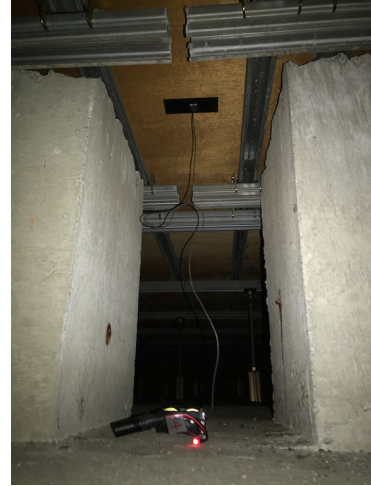
図 4: 床裏に設置された触感センサ
